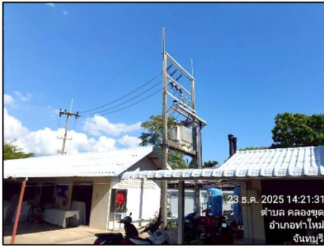
เสาไฟฟ้าและหม้อแปลงไฟฟ้าภายในโครงการ มีระยะห่างจากอาคารอื่นอย่างปลอดภัย
