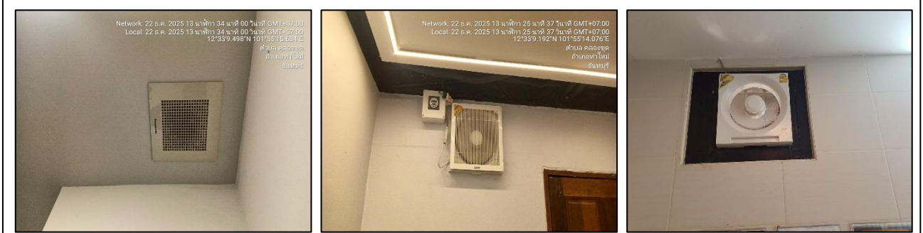
ช่องระบายอากาศและพัดลมระบายอากาศในอาคาร
